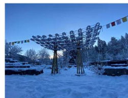
2021-2024 Nachhaltigkeits-Pavillon (Montessori-Schule Penzberg)
